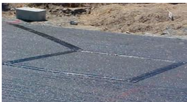
Εικόνες 4.11 και 4.12: Απλός επαγωγικός βρόχος σε σχεδιαστική απεικόνιση (αριστερά) και μετά την εγκατάσταση (δεξιά)
