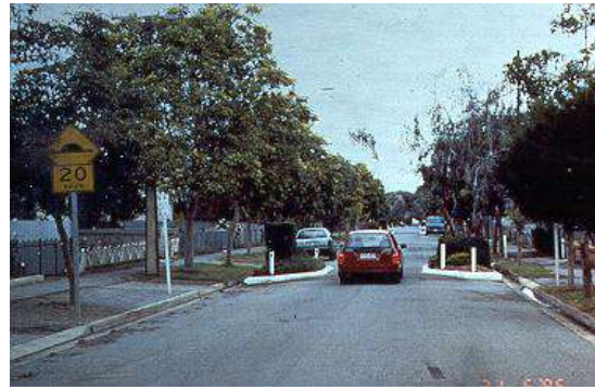
Στένωση οδού μέσω επέκτασης πεζοδρομίου (1)
