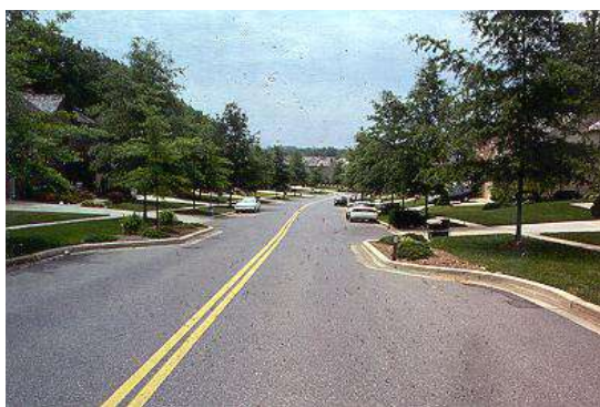
Στένωση οδού μέσω επέκτασης πεζοδρομίου (2)
