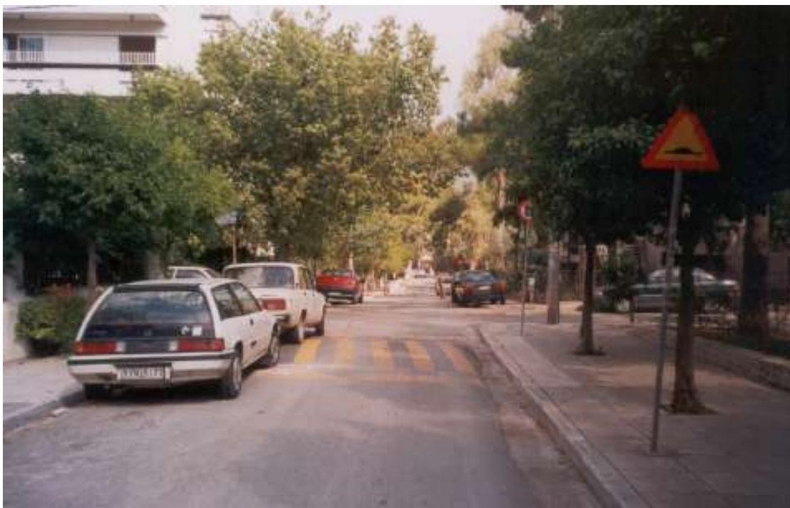
Εικόνα 5.3: Τοπική υπερύψωση οδού και αντίστοιχη σήμανση στο Νέο Ψυχικό. (Πηγή: προσωπικό αρχείο)
