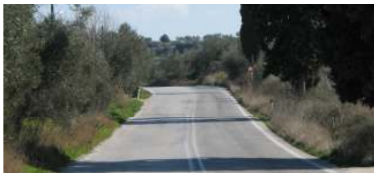
Σχήμα 10: Φωτογραφία προσέγγισης στην επικίνδυνη θέση (χλμ.19,0) - κατεύθυνση φωτογράφισης προς Λυγουριό
