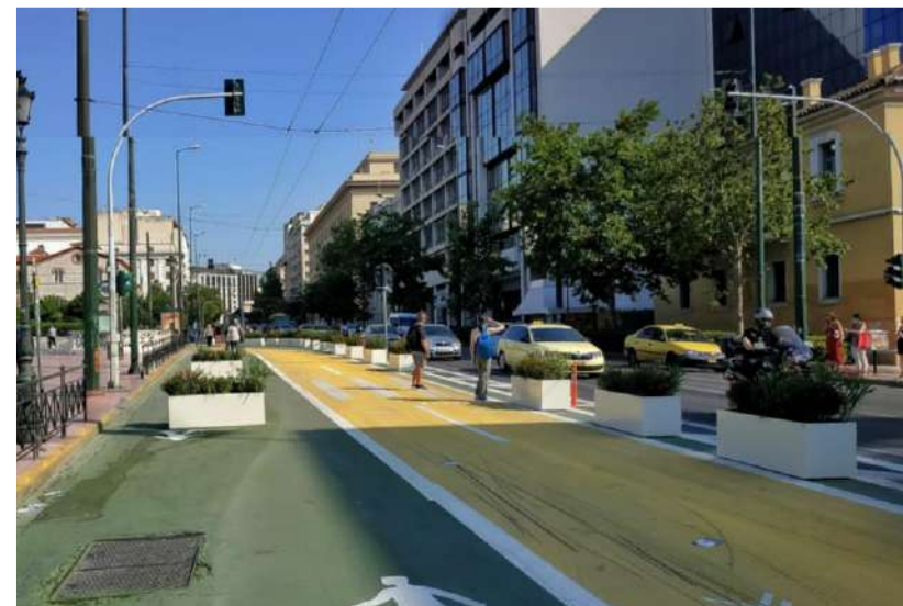
Ανακατασκευή δημόσιου χώρου
