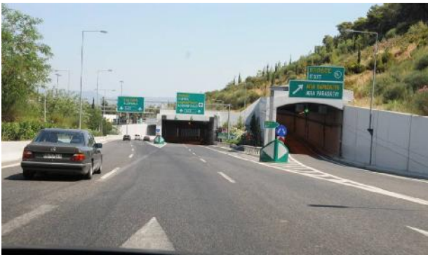
Φωτογραφία 5. Διαχωρισμός ρευμάτων προς Ελευσίνα και προς Αεροδρόμιο σε λωρίδα δύο επιλογών
