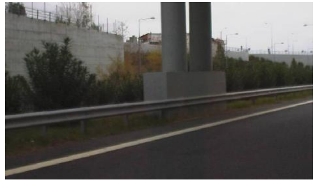
Φωτογραφία 8. Μεσόβαθρο γέφυρας σε επαφή με το πλευρικό στηθαίο ασφαλείας Picture 8. Bridge pier in contact with guard rails
