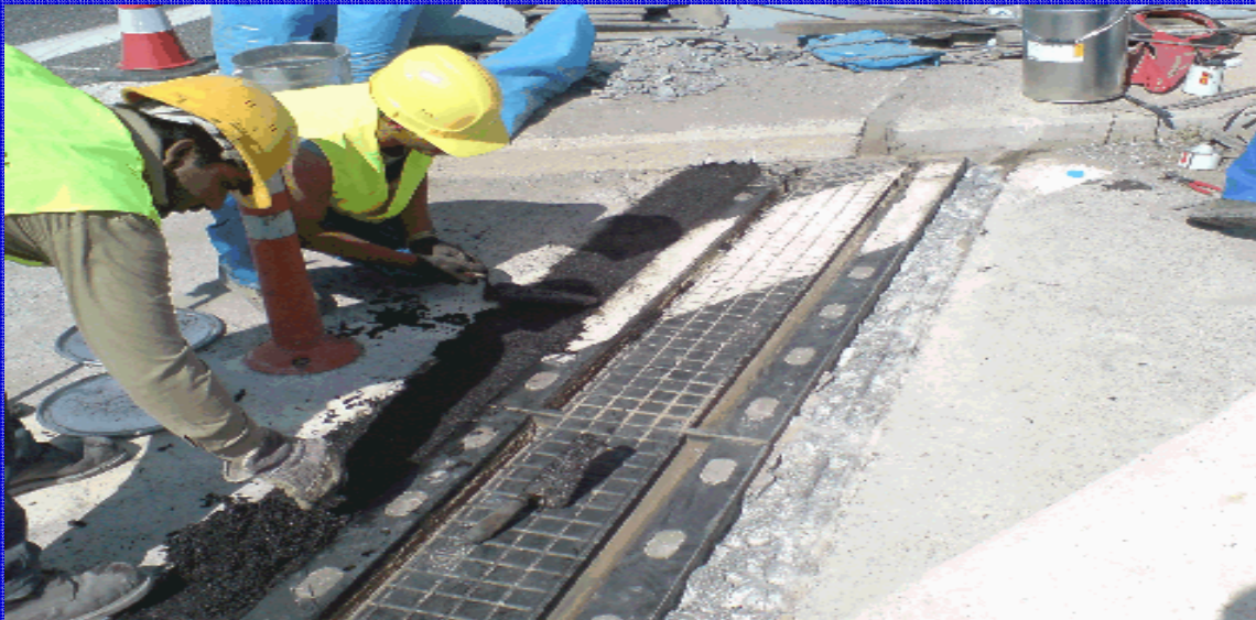
Λεπτομερής Επιθεώρηση και επί τόπου επισκευή αρμών από εξειδικευμένο συνεργείο
